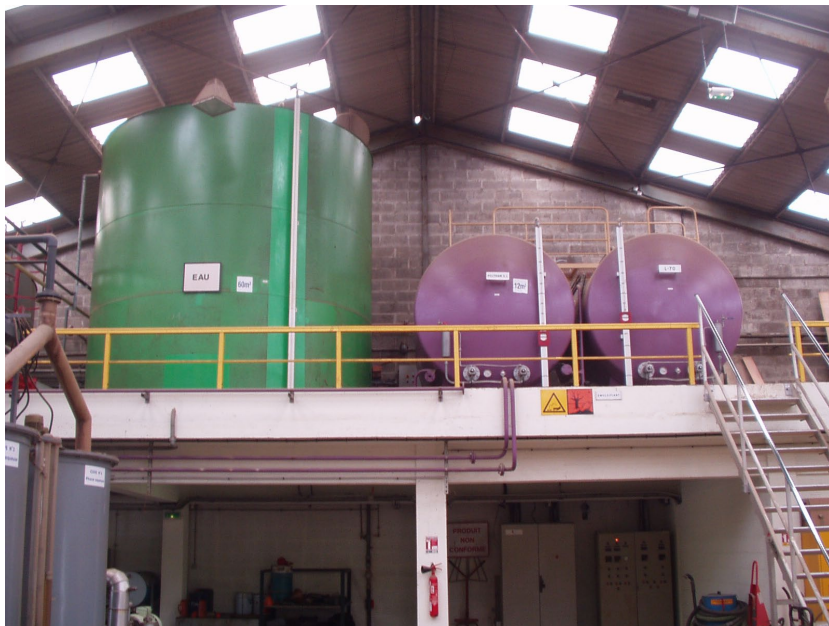
Figure3 : cuves eau, acide
