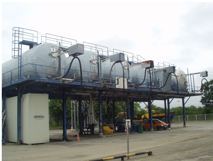
Figure 4 : cuves de stockage de l'émulsion avant chargement
