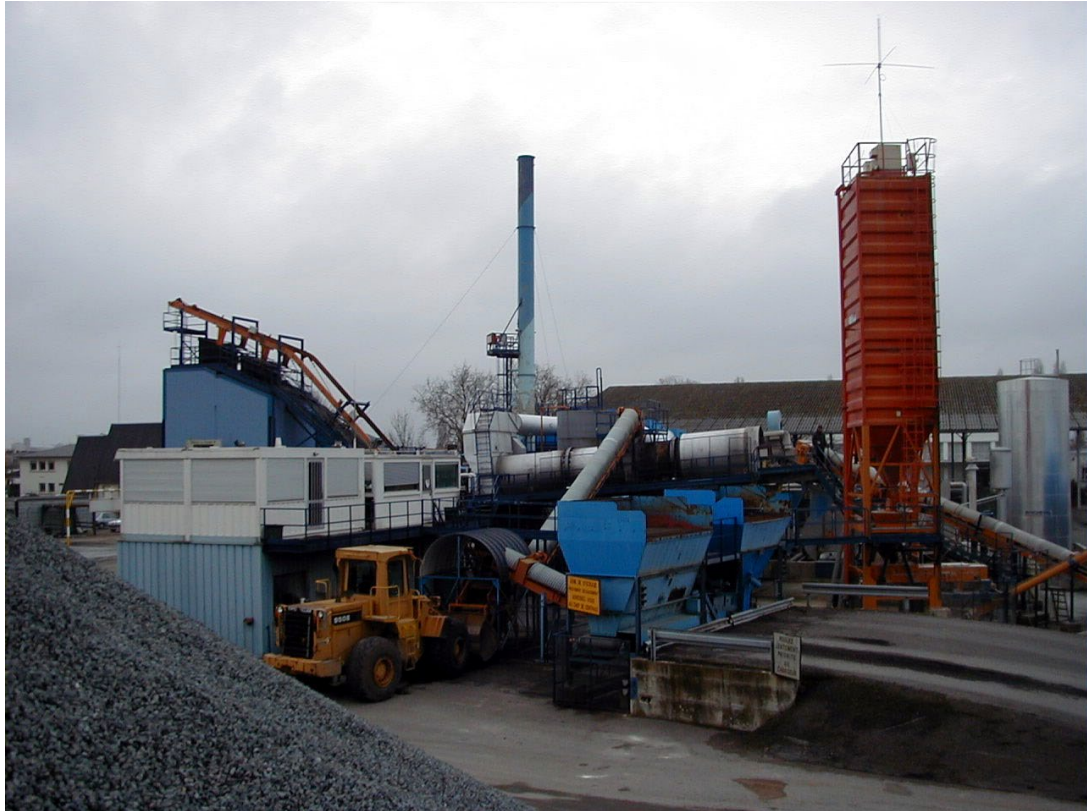
Photo 1 : vue d'ensemble d'une centrale d'enrobage (centrale Blois)
