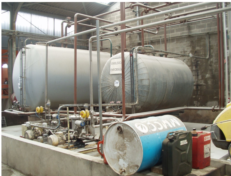
Photo3 : stockage de l'émulsion avant introduction dans le malaxeur
