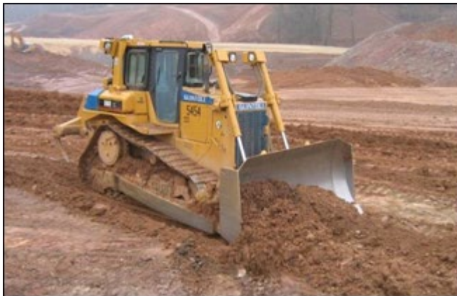
Figure 7 : Bulldozer D6R équipé de scarificateurs en cour de régalage.
