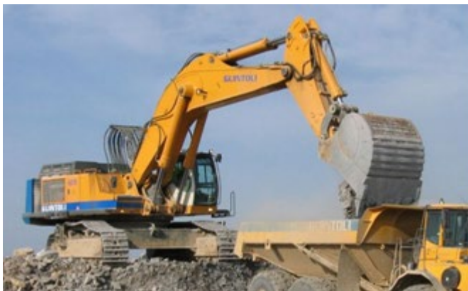
Figure 4 : La pelle 974 en cours de chargement d'un dumper.
