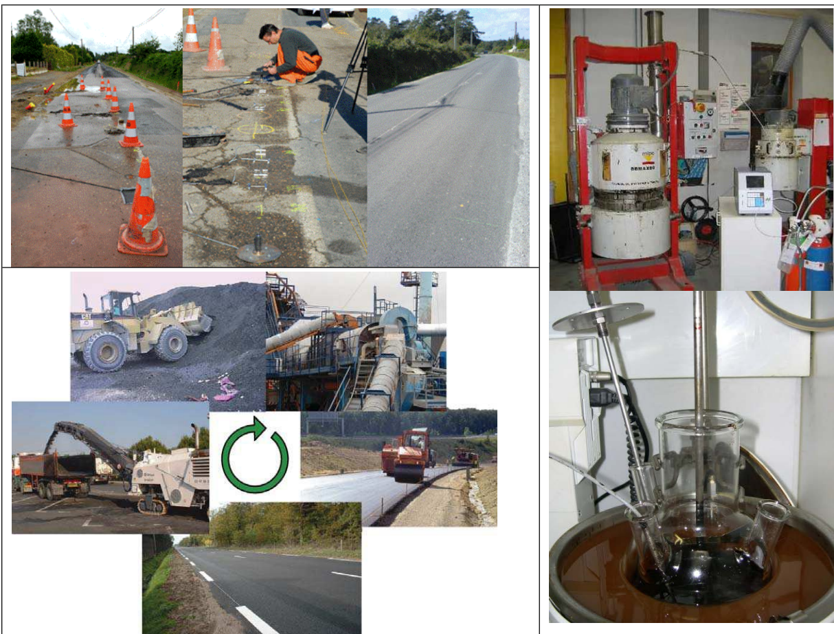
Photographies: Chantiers de graves-émulsion instrumentés (en haut à gauche), Projet Européen Re-Road (en bas à gauche), Dispositif de génération, prélèvement et d'analyses de fumées d'enrobés et de bitume (à droite)
