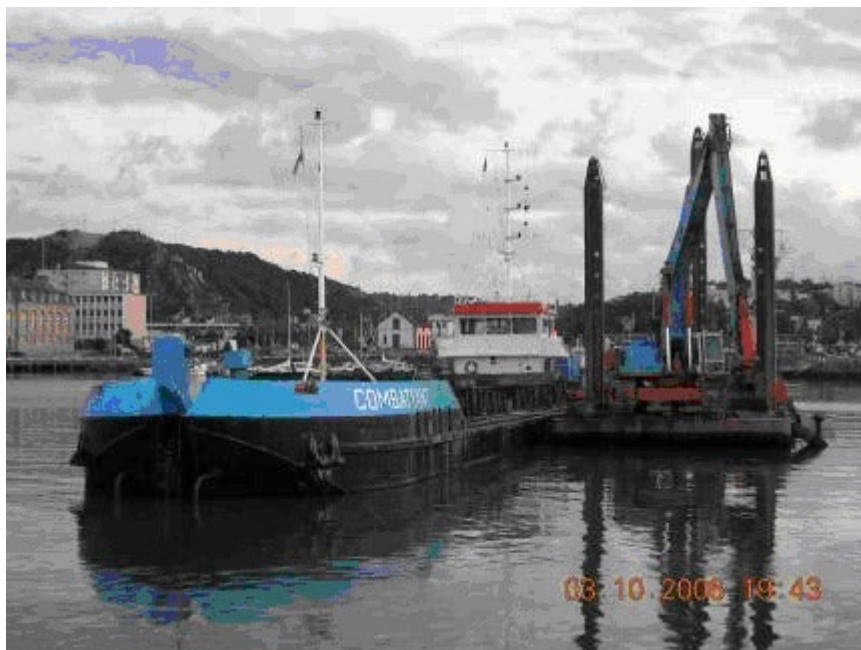
Figure 1 : Dragage mécanique à pelle et chaland «Combattant » associé (Source : Bénard)
