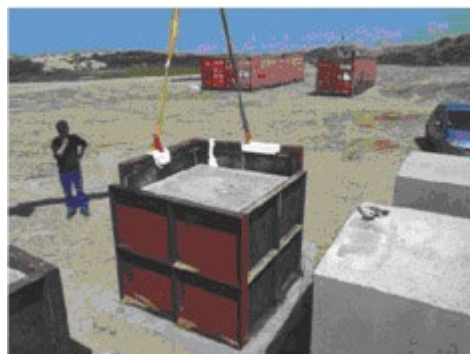
Figure 8 : Fabrication des cubes-acropodes incorporant des sédiments traités au liant AliEco®.
