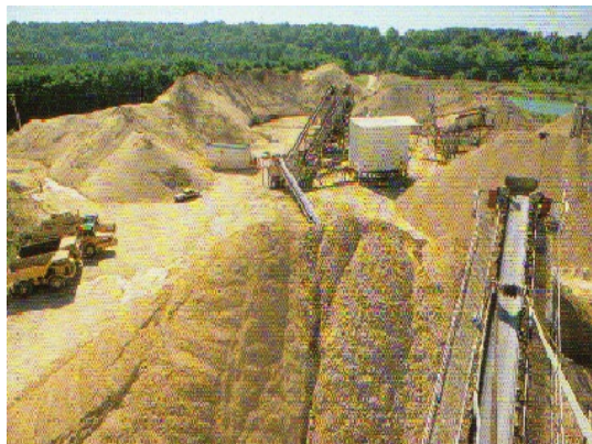
Figure 2 : exemple de bandes transporteuses d'installation de traitement d'une carrière (Source : Cemex).
