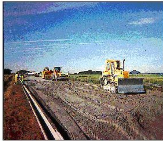
Figure 2 : Mise en œuvre de Cendre-Volante-Chaux-Gypse (in OFIR1)
