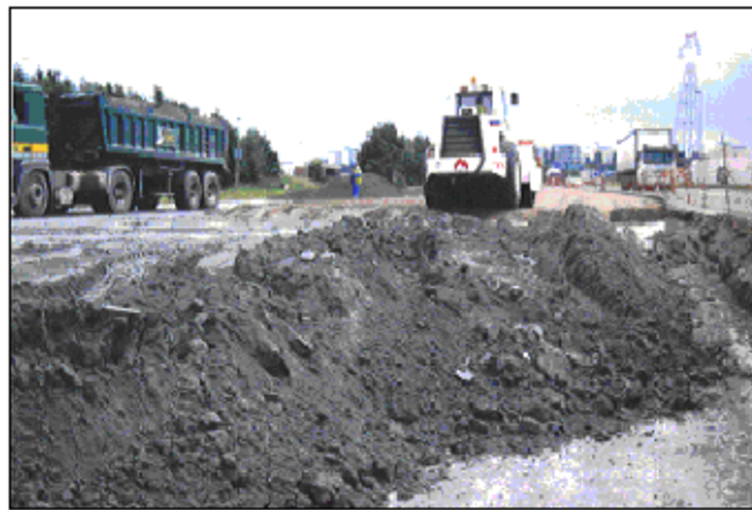
Figure 1 : Exemple d'utilisation en terrassement
