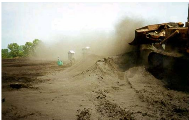
Figure 5 : Photo illustrant la mise en place des capteurs de mesure d'exposition aux poussières de silice dans un chantier de l'état de l'Indiana – remblai en mélange de sable de fonderie usé et de poussières de filtres [Afzal W. et al. , 2002].
