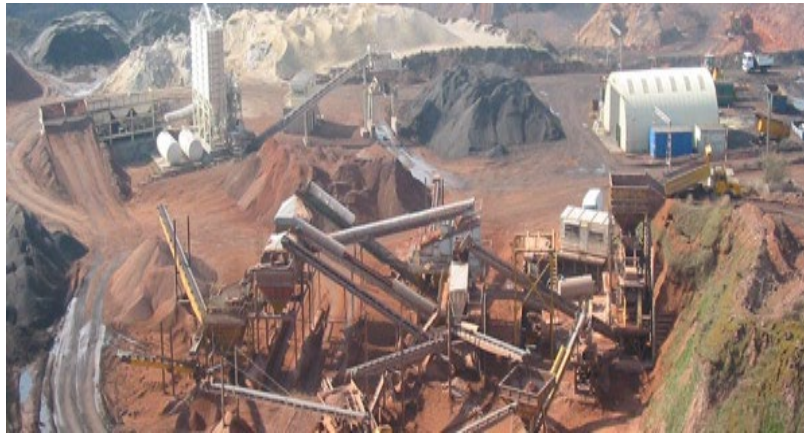
Figure 5 : Installation de concassage criblage (crédits SCA)
